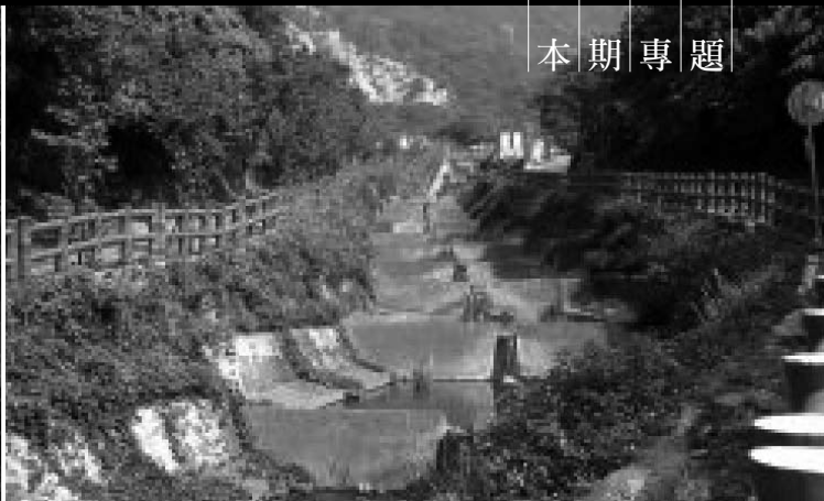
▲ 水磨坑溪跌水工法
