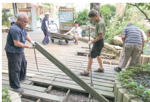
▲6.30 永修精舍翻修木地板
