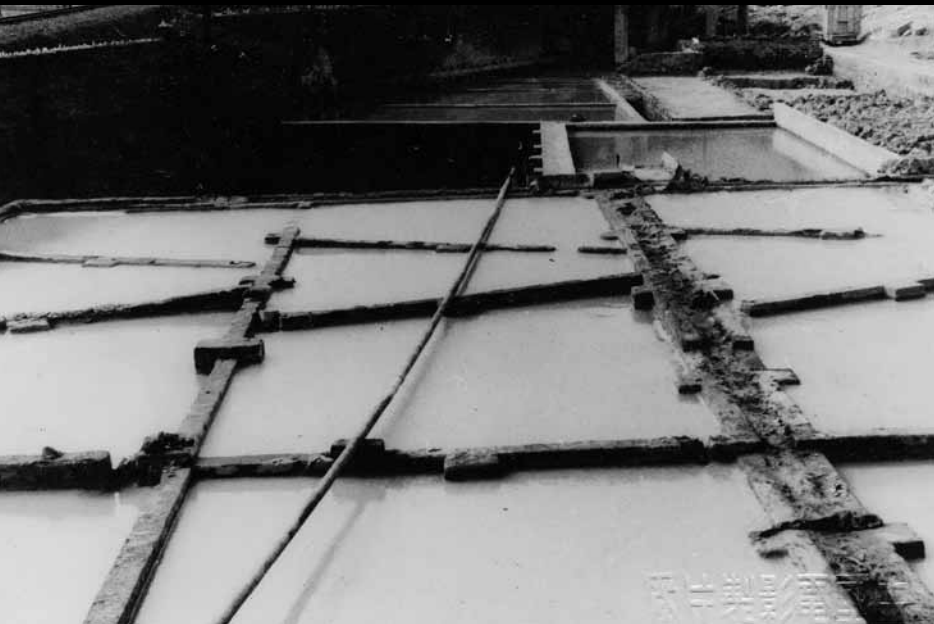
▲ 北投貴子坑黏土水煎場老照片
