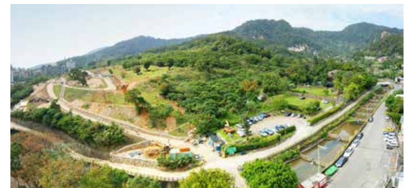
圖右：2019.7 覺風園區前端「三層崎公園」竣工。
