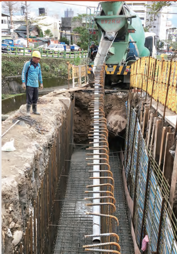
般若橋施工狀況
